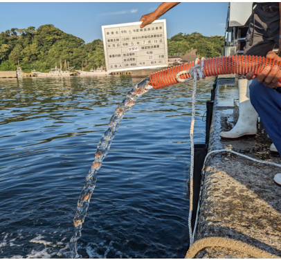
ホースによる岸壁放流
